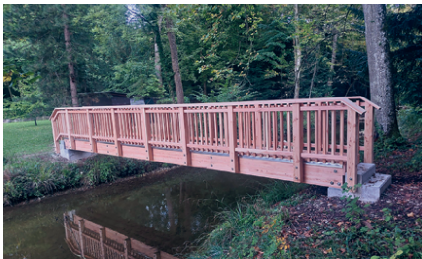
Un nouveau pont enjambe le vivier.
