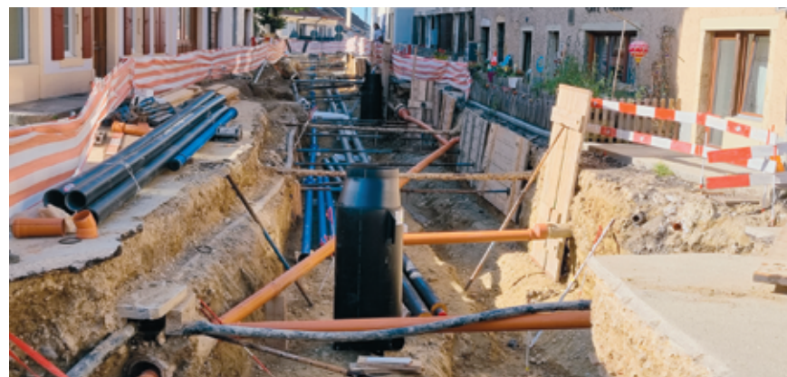
La rue du Centre en travaux.
