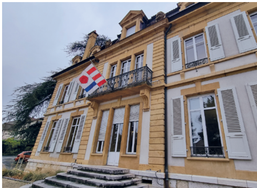
Le bâtiment de l'administration communale à Saint-Aubin.
