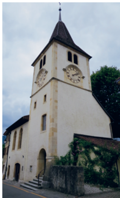
Des réparations seront bientôt apportées à la toiture du temple de Bôle qui a été endommagée lors d'une tempête en fin d'année dernière. Photo SP
