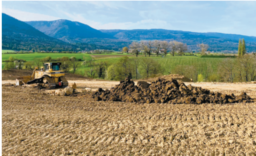
Vue du chantier: pas de panique, l'endroit retrouvera son aspect d'antan!
