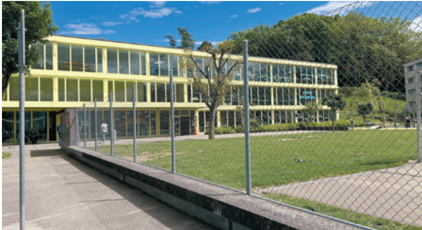
L'état du collège des Mûriers déçoit après seulement vingt ans d'utilisation. Photo Sophie Bourquin
