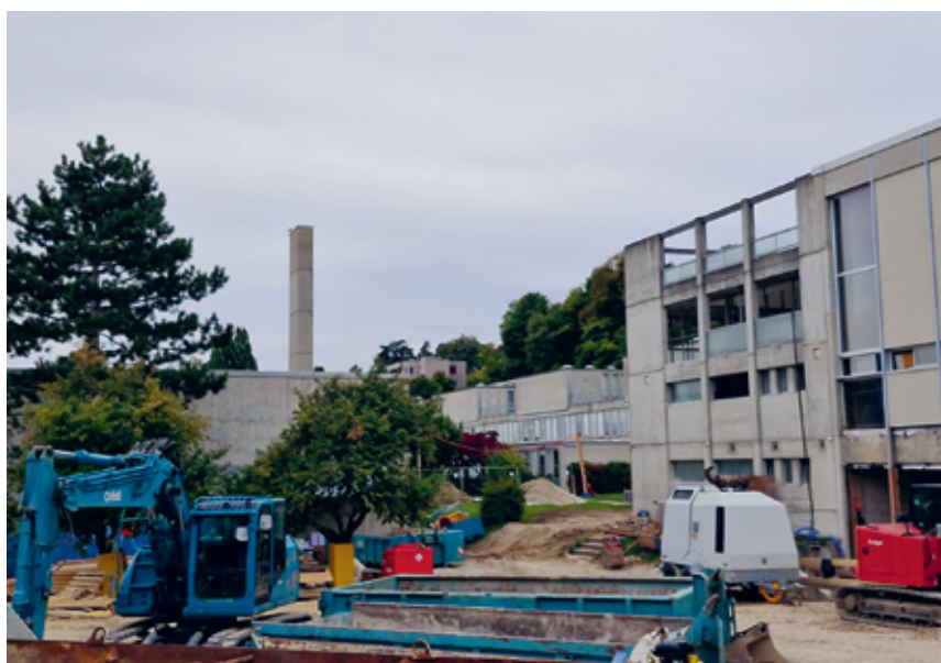
Les travaux d'assainissement et de construction doivent durer trois ans.
