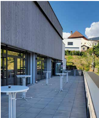
La galerie extérieure.
