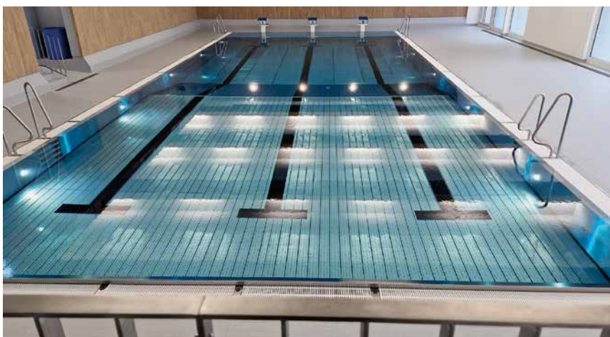
Le nouveau bassin de la piscine, d'une profondeur maximale atteignant 3 mètres.
