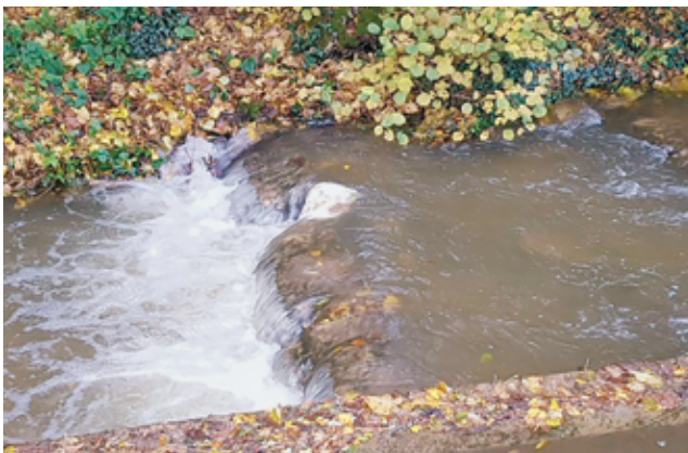
Le saut dans le lit du ruisseau empêche la migration piscicole.
