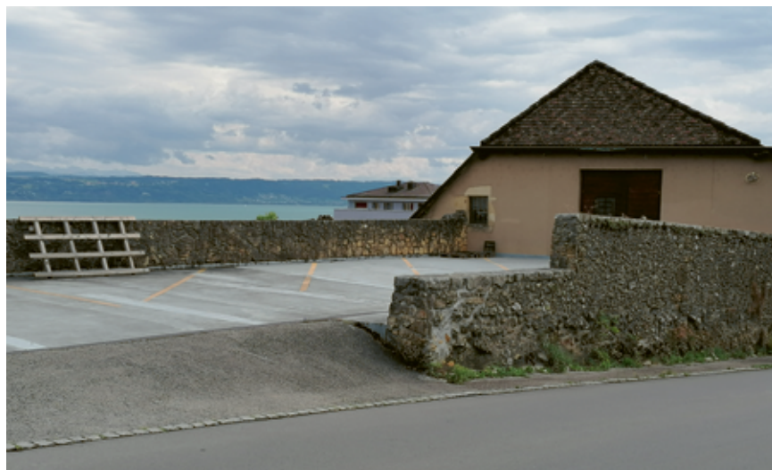
Le bouteiller a été construit sous le parking.
